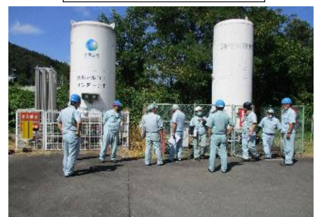
高圧ガス漏洩時の処置確
