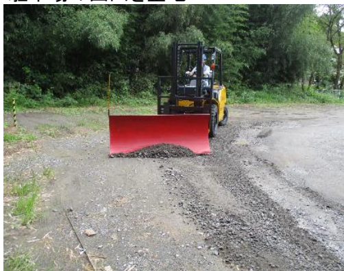
駐車場の凸凹を整地
