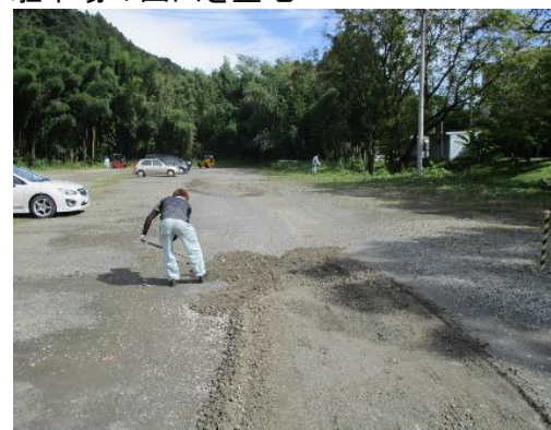
駐車場の凸凹を整地
